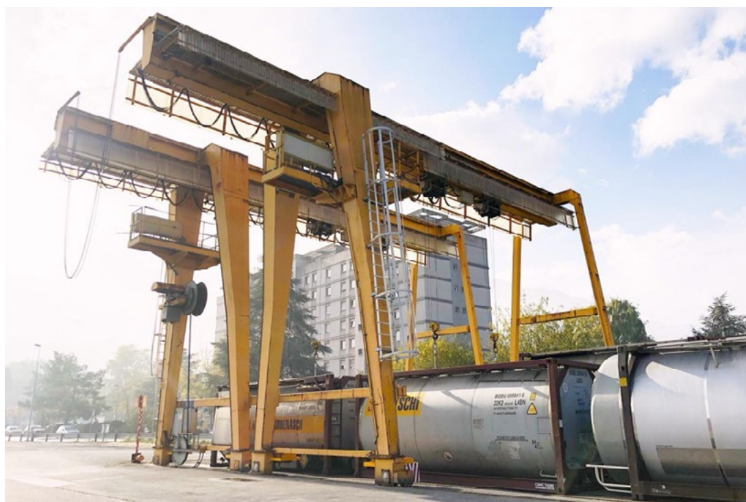
Image 3 : Terminal combiné de Bertschi à la gare CFF de Monthey – état en 2018
